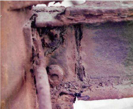
Figura 28. Imágenes del estado del muelle que muestran su deterioro
