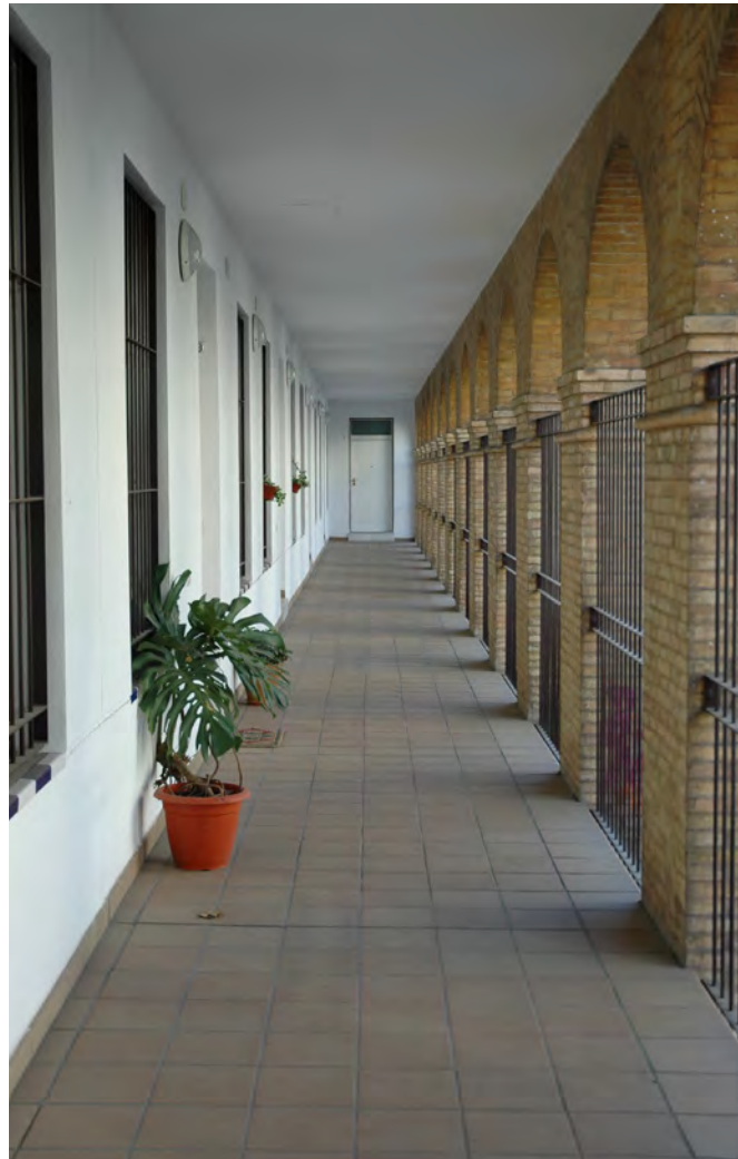
Figura 10. Edificio de viviendas en avenida de Ramón y Cajal. Aníbal González, 1922. Archivo: Capilla, Ramos, Sánchez-Cid
