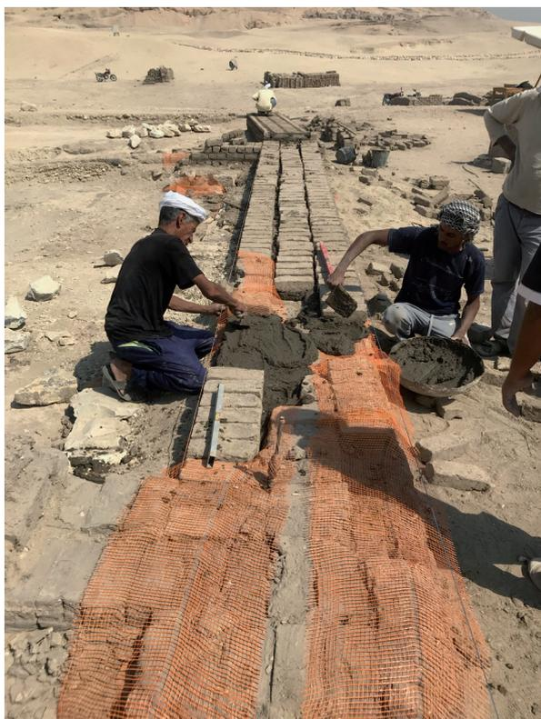
Figura 4. Protección de un muro de adobe
