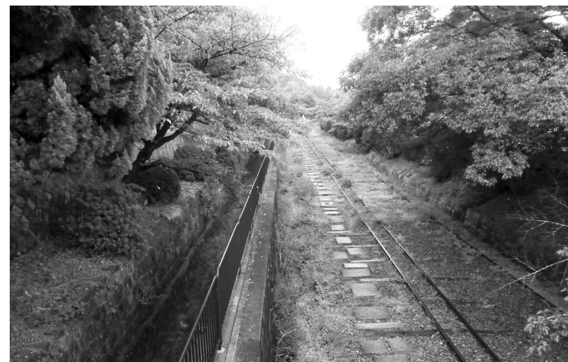
Fig. 13 - Acceso al lago Biwa desde Kioto, Japón. Un camino de piedra acompaña el recorrido que tomaban las barcas cuando eran transportadas a través de esta vía férrea que comunicaba con el lago. Fot. Autora del libro, 2013.
