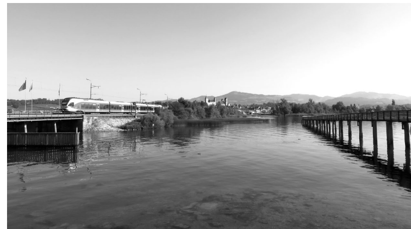
Fig. 16 - La pasarela peatonal de Rapperswil, construida a imagen de la antigua de origen medieval, se mide con el dique construido para el ferrocarril en el s. XIX. Lago de Zúrich, Suiza. Fot. Autora del libro, 2016.
