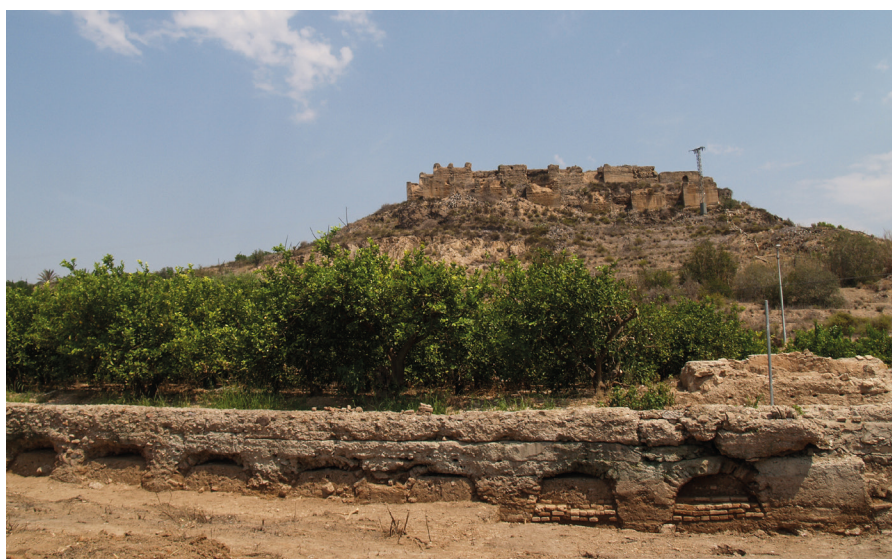
Castillejo de Monteagudo (Murcia). En primer plano podemos apreciar la presencia de un acueducto construido con tapial de hormigón y arcos de ladrillo. Al fondo, sobre la colina, se alza el palacio fortificado que presidió la finca de recreo de Ibn Mardaniš. Fotografía realizada en septiembre de 2018 durante los trabajos de excavación.
