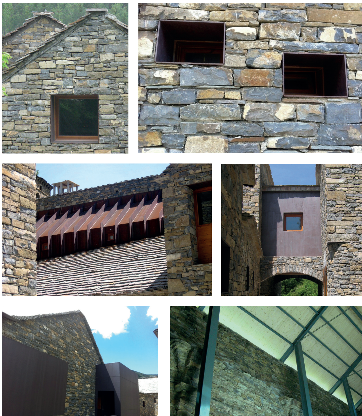
Figura 1.8. Resultado final de la estrategia de elementos originales y añadidos. De izquierda a derecha y de arriba abajo: codificación de nuevos huecos, volúmenes de conexiones en altura, nuevas piezas de acceso desde el exterior a las viviendas y elemento de cubrición de la iglesia. Fotografías del autor
