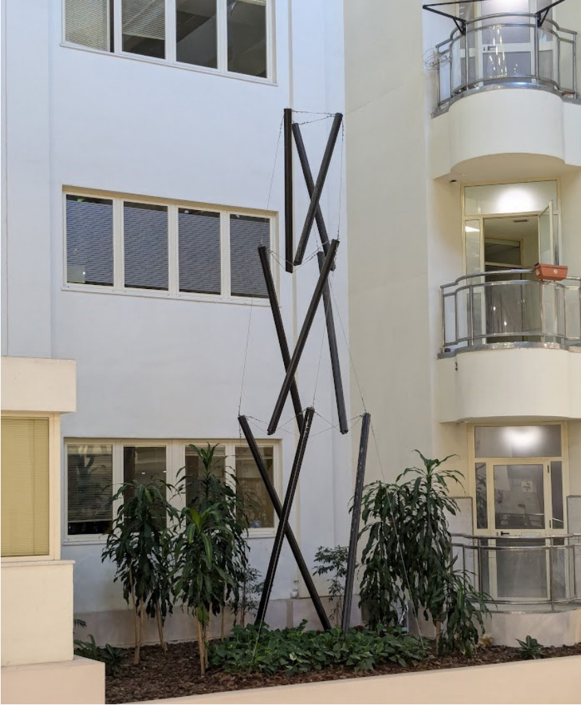
Figura 7. Tensegridad en la ETSI de la Universidad de Sevilla
