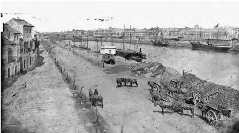
Fig. nº 2. Vista de la calle Betis a principios del siglo XX, antes de su pavimentación. © ICAS-SHAP. Fototeca Municipal de Sevilla.
