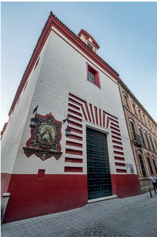
Fachada y portada de la Iglesia de San Buenaventura en la calle Carlos Cañal, comenzada a construir en el año 1605
