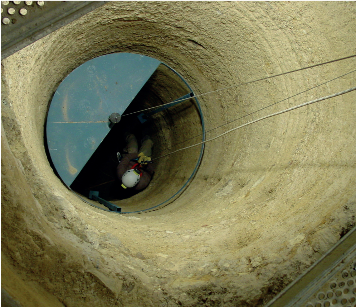
Figura 13. Sistema de protección para el izado de materiales del relleno del pozo de Menga. Fotografía: Francisco Carrión Méndez.
