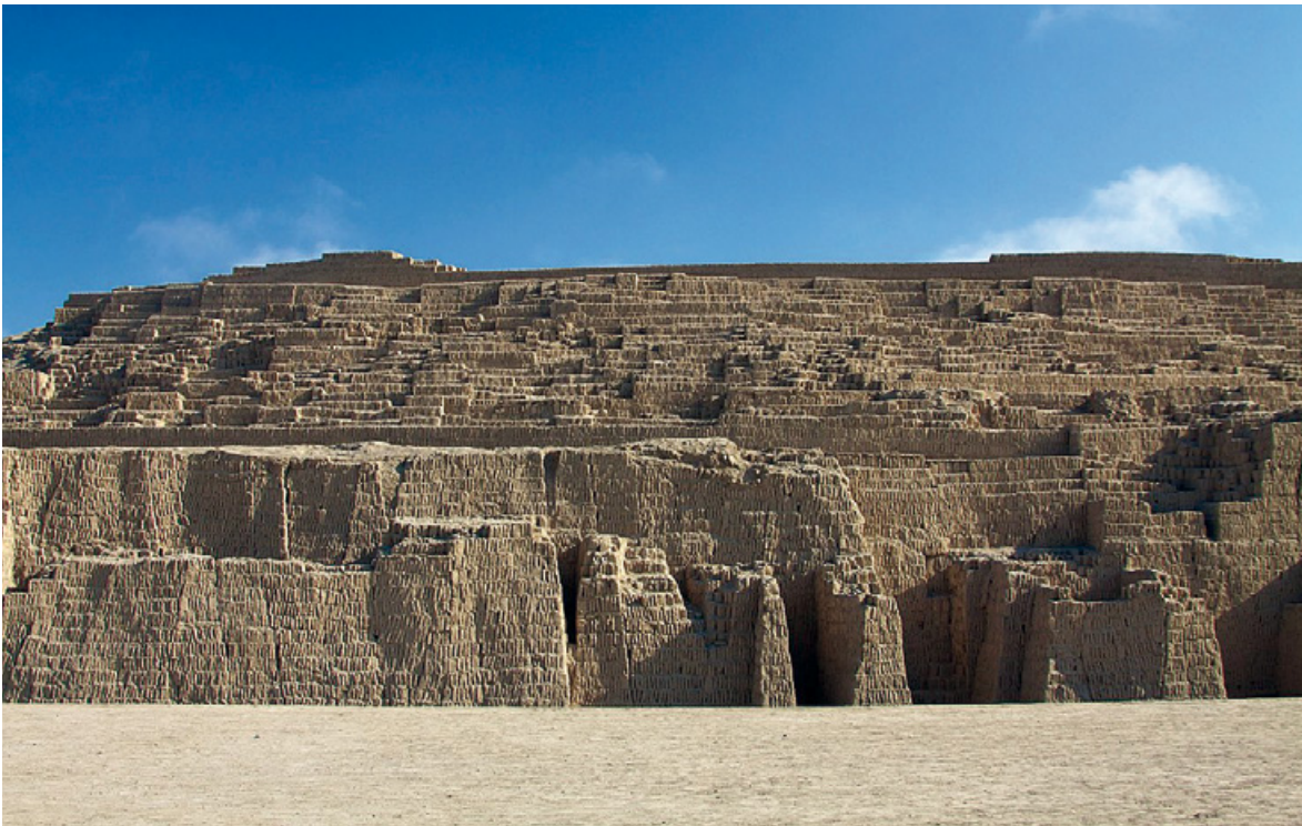
Figura 5. Huaca Pucllana (Miraflores). Se puede observar el uso en su construcción de «adobitos» propios de la Cultura Lima.
