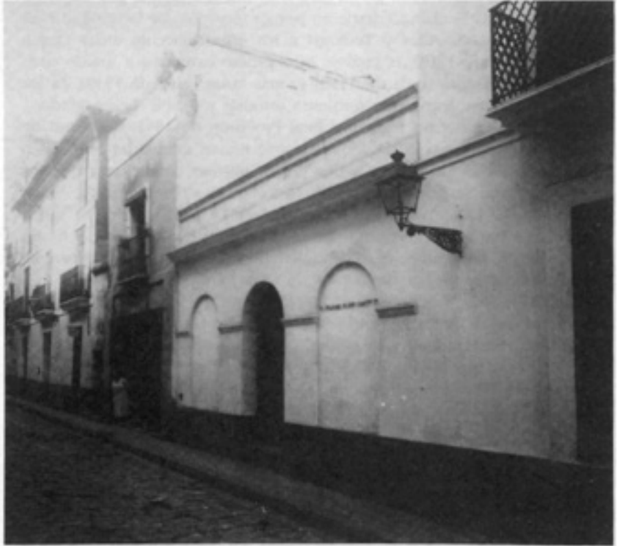
Lám. IV. Fachada del Ex-convento de Santo Tomás, a la calle Aduana (Fot. J. M. a Grandín, Sevilla, Facultad de Geografía e Historia, Laboratorio de Arte, Arch. Fot. caja 424).
